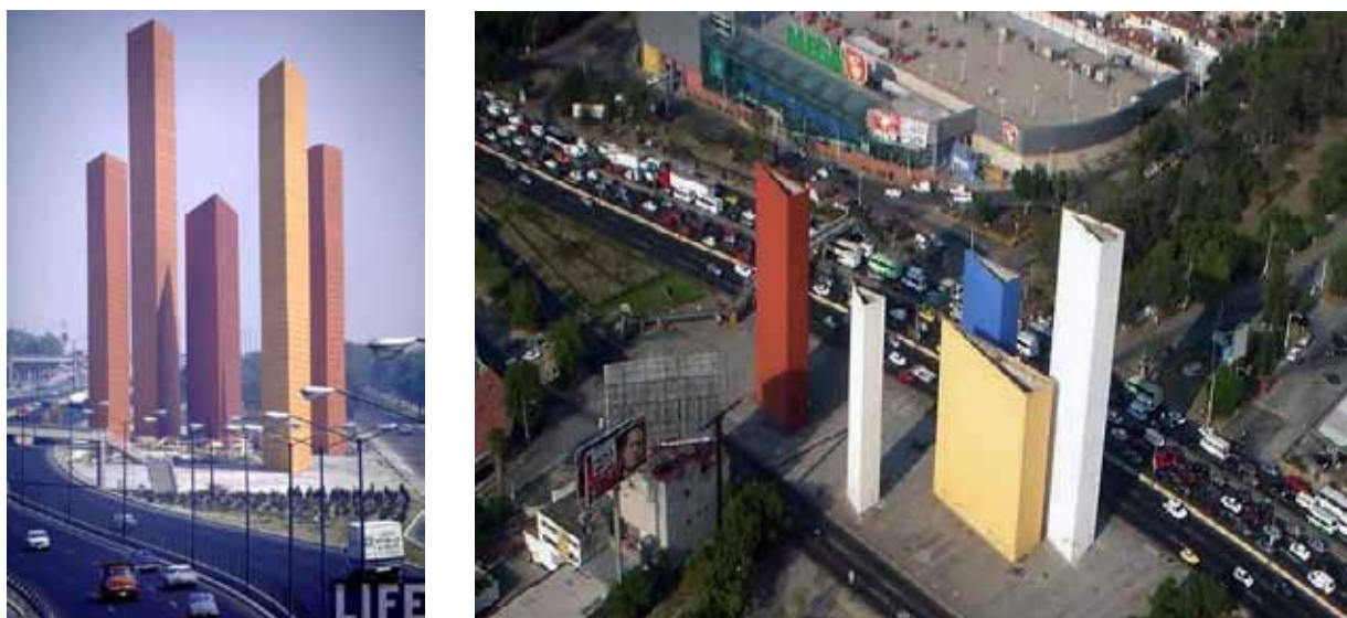
Figuras 15 e 16 – Torres em 1968; Cores escolhidas por Goeritz em 1989 Fonte: < http://www.nervion.com.mx/web/casos/satelite.php > Acessado em: 15/11/2015
