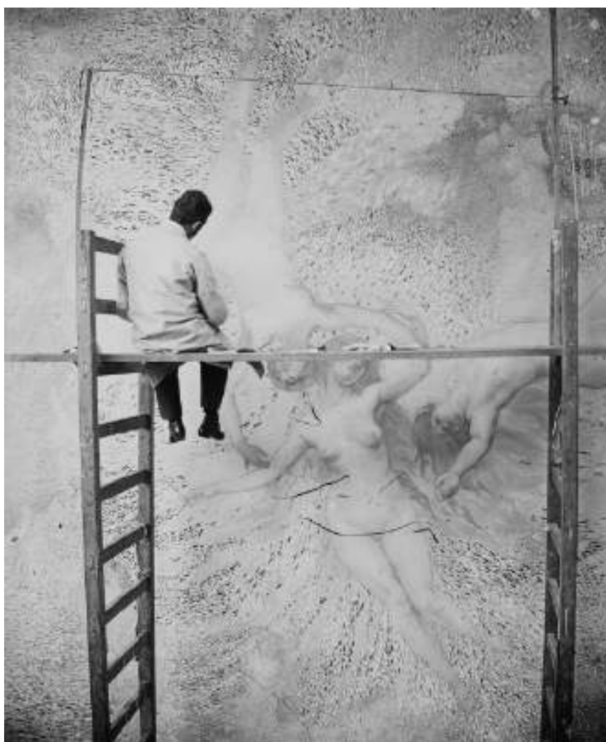
FOTÓGRAFO ANÔNIMO. Eliseu Visconti no andaime com o painel central do foyer, Paris, c.1915.
